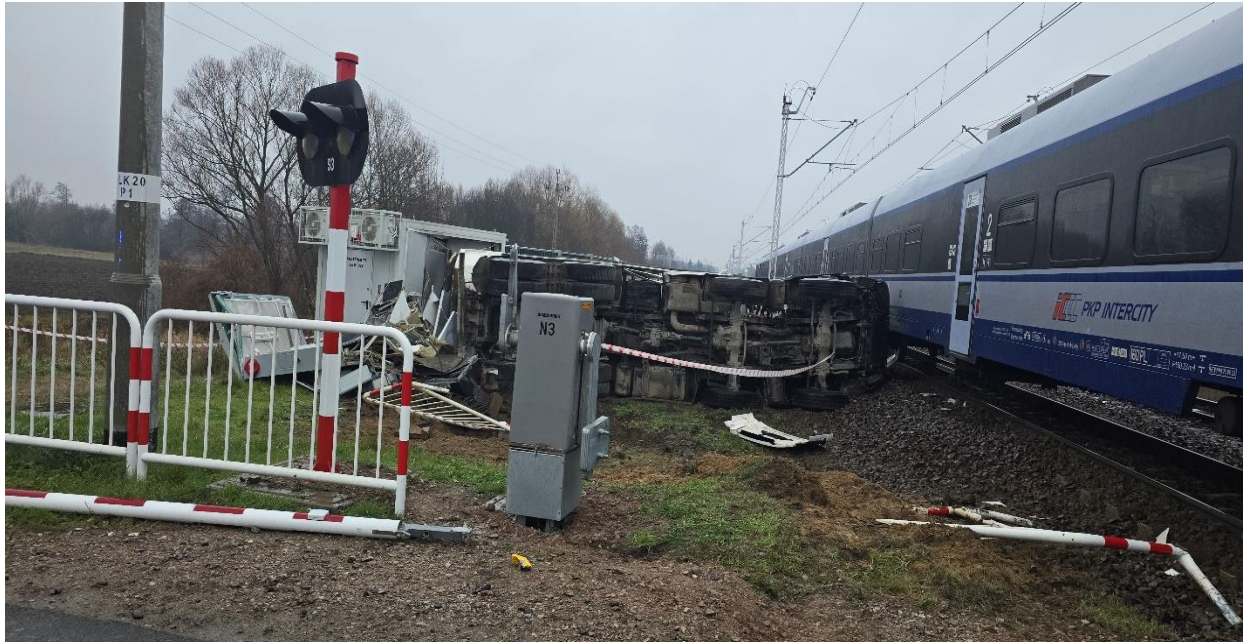
Zdjęcie 1 – Skutki zdarzenia w rejonie przejazdu – uszkodzona infrastruktura i urządzenia zabraniające wjazdu na przejazd (fot. komisja kolejowa)
