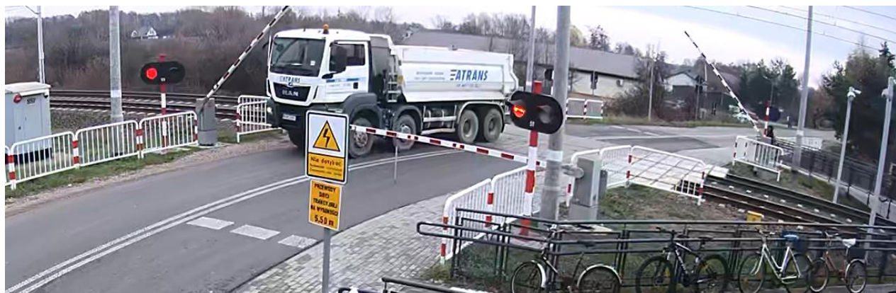
Zdjęcie 10 – Widok z kamery od strony napędu N2 - zatrzymanie się samochodu ciężarowego przed opuszczającą się rogatką zjazdową napędu N3 (źródło: PKP PLK S.A.).
