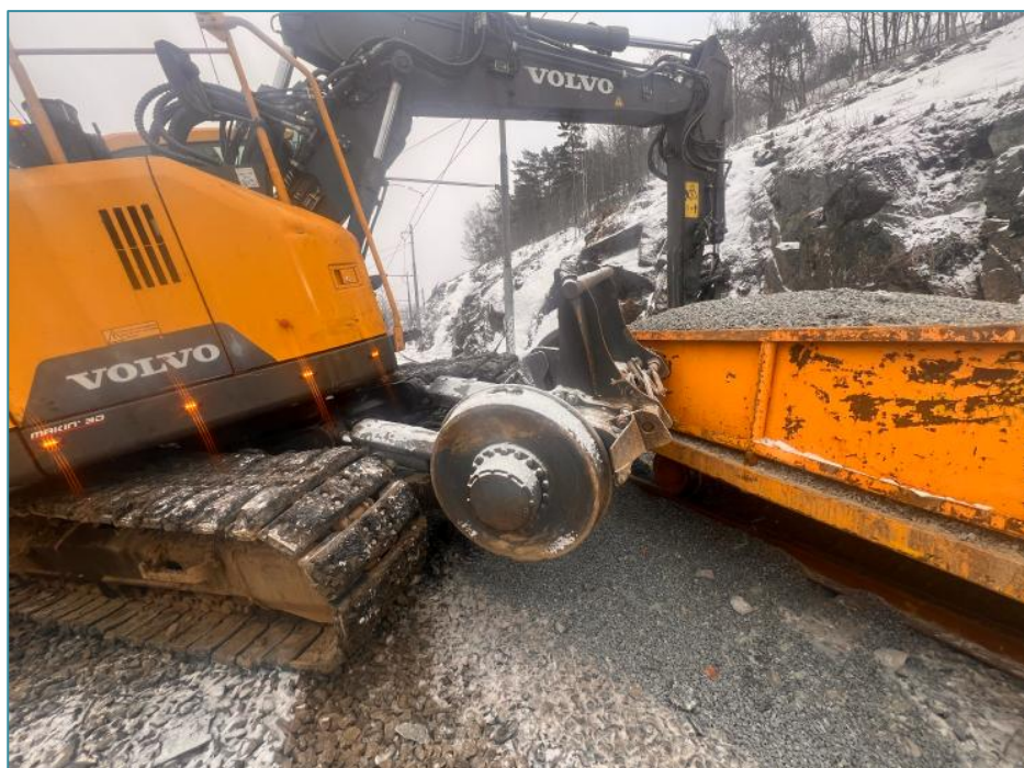
Figur 1: Fra hendelsesstedet. Kilde: Synergimelding, Sporveien Trikken AS
