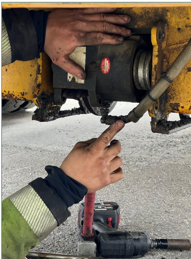
Figur 11: Løs tilkobling av hydraulikkslange. Foto: SHK
