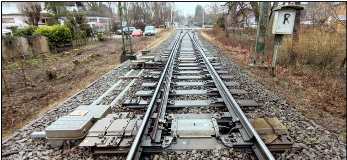
Abbildung 8: Aufgefahrene Weiche W1
