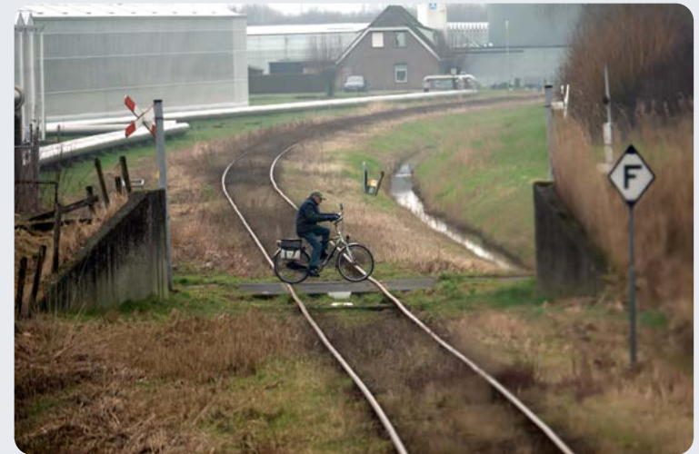
Figuur 19: Voorbeeld van één van de andere onbeveiligde overwegen op het baanvak Lag Zwaluwe – Oosterhout Weststad waar het zicht volledig belemmerd is door een betonnen wand aan beide zijden van de overweg (februari 2025) (bron: Onderzoeksraad voor Veiligheid).
