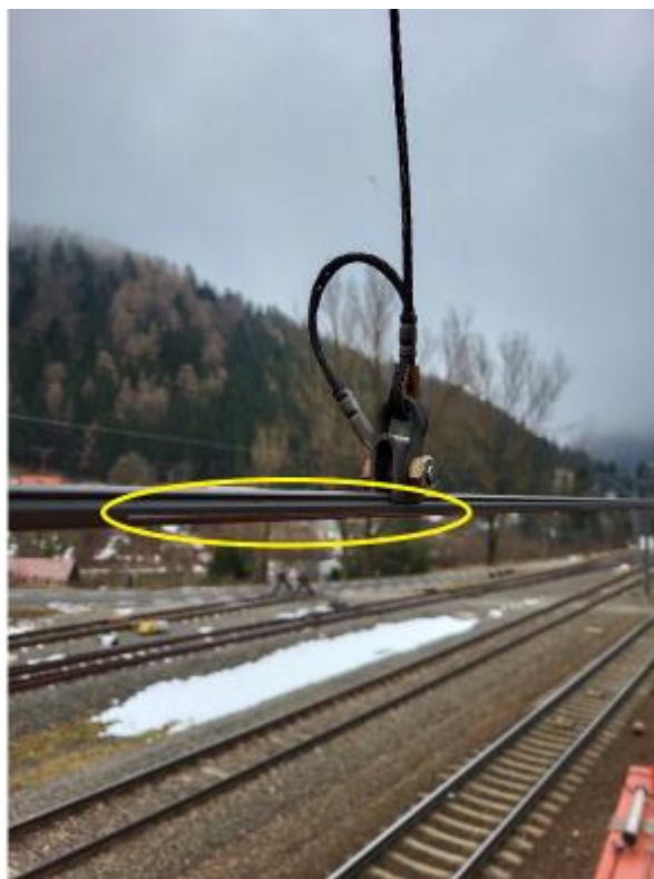
Foto nr.10 și nr.11 – prima urmă de frecare nouă pe firului de contact corespunzător liniei directe nr.II
