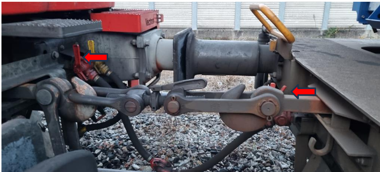
Fig. 11 – Rubinetti freno pneumatico in posizione verticale (chiuso) (Fonte: personale RFI intervenuto dopo arresto del treno).
