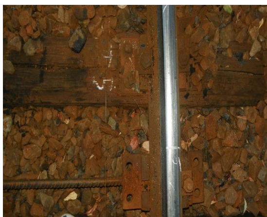
Foto.nr.6 - Traversa T 5
