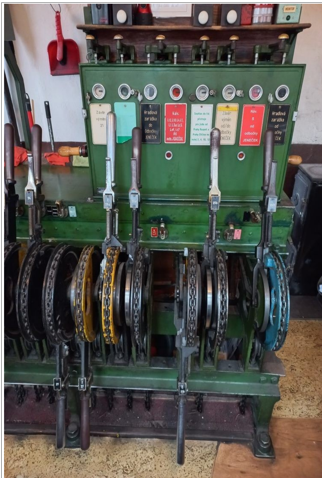
Obr. č. 5: Pohled na stavěcí páku výhybky č. 25b v nesprávné poloze (neodpovídající zobrazení na štítku kolejového číselníku) a nezaklesnutou závorníkovou páku Z 25b
