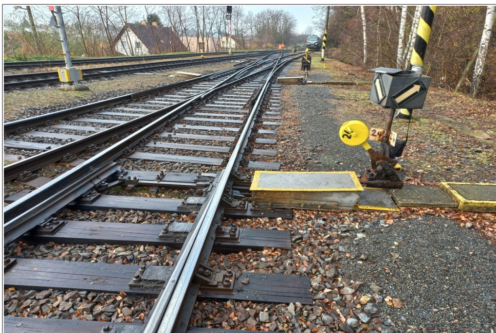
Obr. č. 7: Pohled na jazyky výhybky č. 24 a křižovatkovou výhybku č. 25ab proti směru jízdy vlaku R 1233 (stav po MU)
