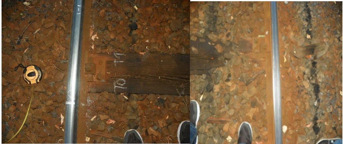
Foto.nr.8 - Traversa T_0 / Traversa T_1
