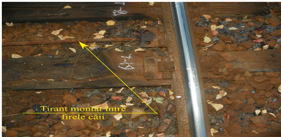
Foto.nr.7 - Tirant montat între firele căii
