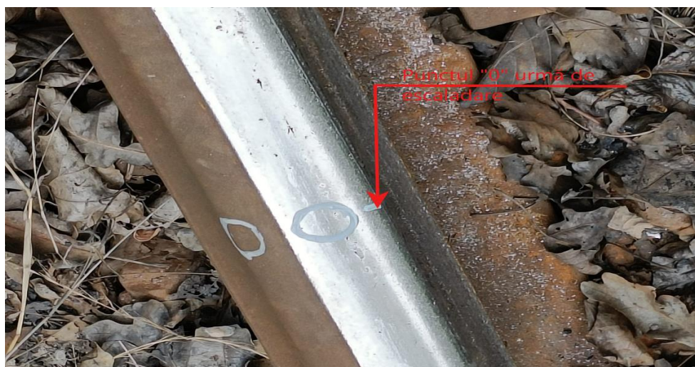
Foto nr.2: Punctul „0” - prima urmă de escaladare la km 18+600 (roata din partea
