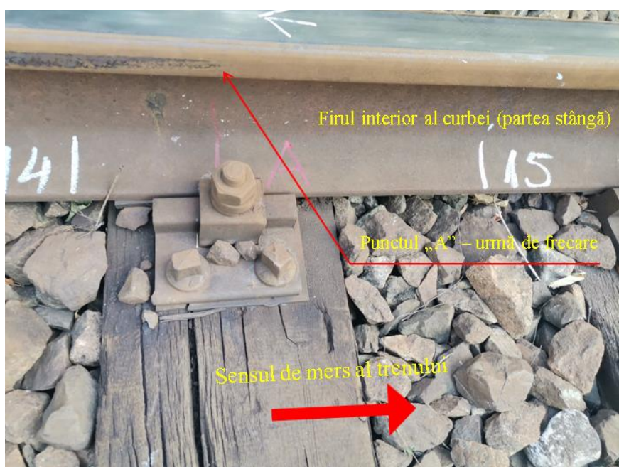
Foto. nr.2 – Punctul „A”: urmă de frecare pe umărul interior al ciupercii șinei
