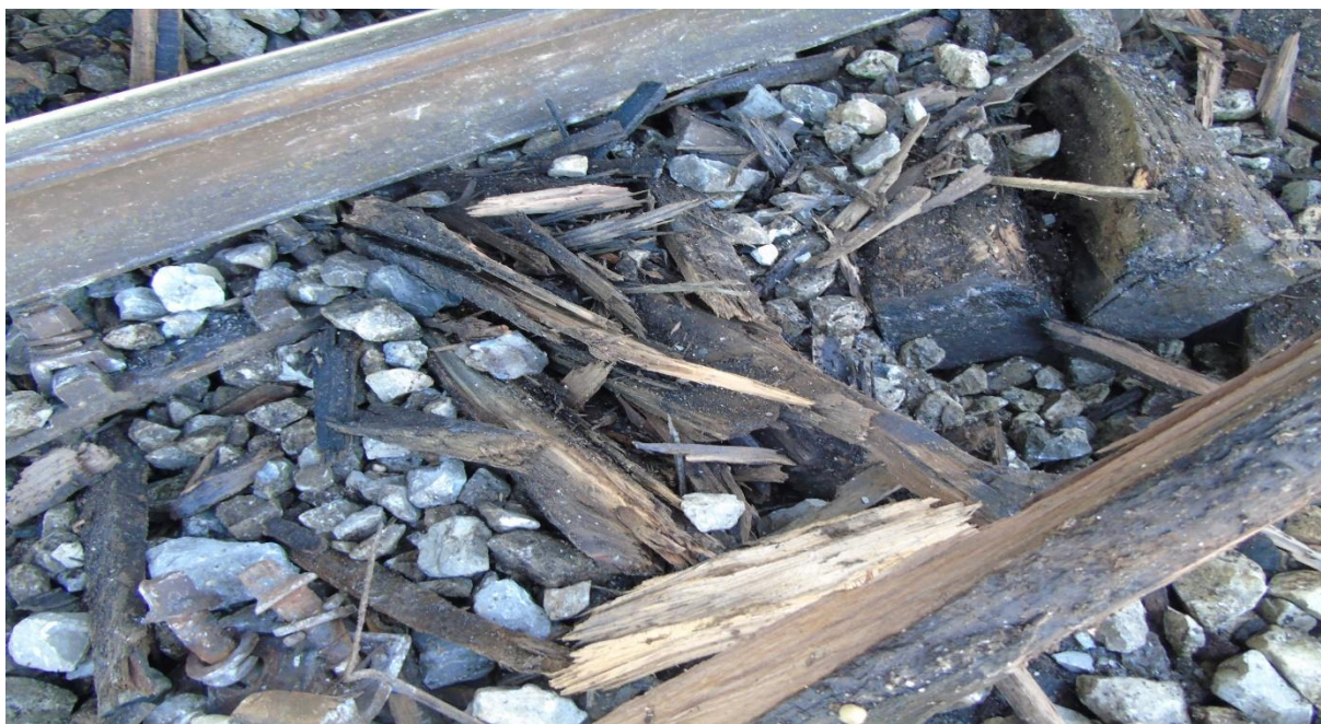
Slika 8. Stanje pragova na 4. kolosijeku nakon nesreće (Izvor slike: AIN)
