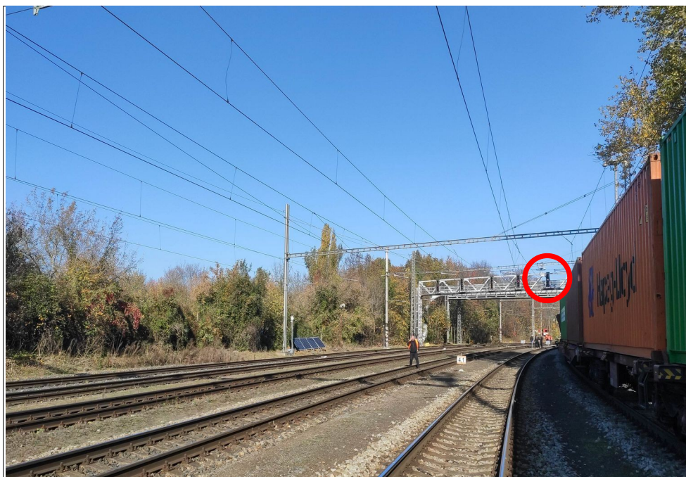
Obr. č. 9: Viditelnost návěstidla S1 z požadované vzdálenosti 156 m
