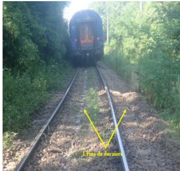
Foto nr.11- Urme de deraiere
