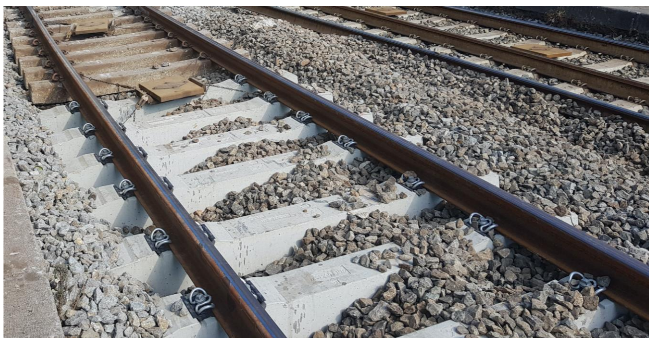
Figura 25 – Rampa di raccordo tra il binario soggetto a rinnovamento e quello non ancora rinnovato (fonte: Ufficio).
