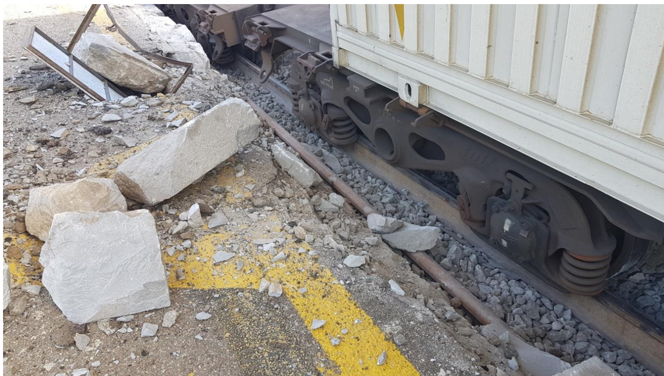
Figura 5 – Danni alla banchina provocati dallo svio del treno n. 64995 ( fonte: Ufficio ).
