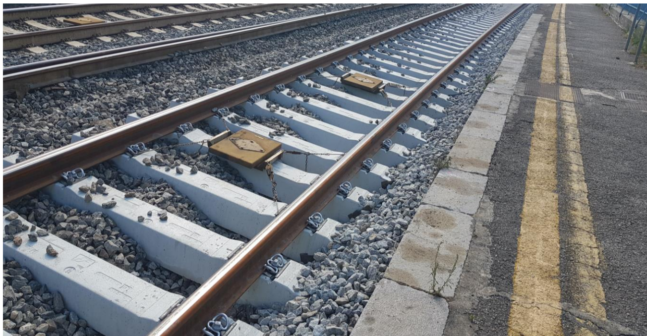
Figura 24 - Tratto di binario soggetto a rinnovamento (fonte: Ufficio)
