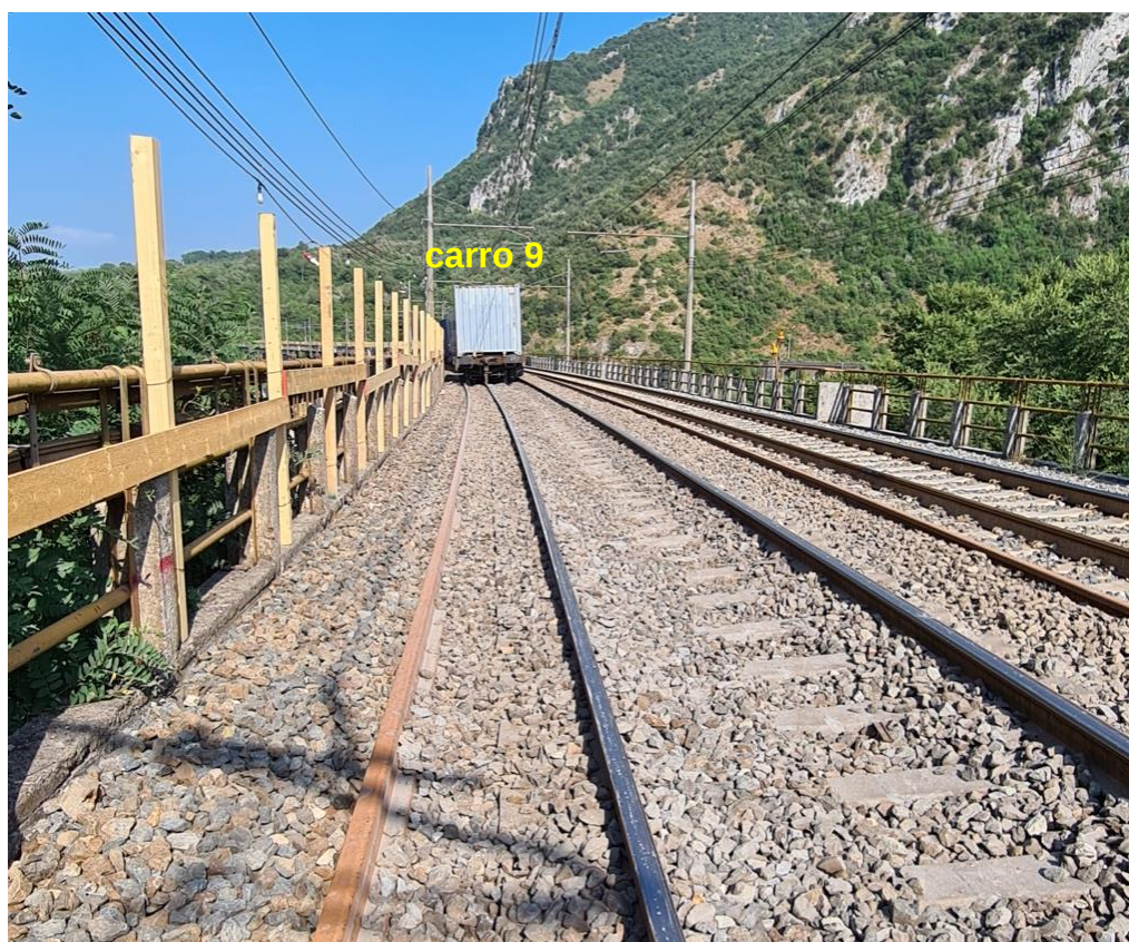
Figura 14 - Particolare del treno n. 64995 dopo lo svio e la rimozione dei carri non sviati (nn. 14, 15, 16 in coda, e nn. 1, 2, 3, 4, 5, 6, 7 oltre al locomotore in testa) – (fonte: Ufficio).
