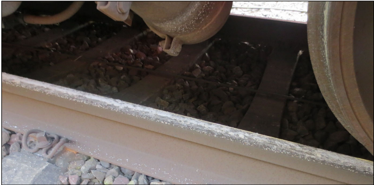
Abbildung 10: Sand auf dem Schienenkopf im Bereich der Weiche 229
