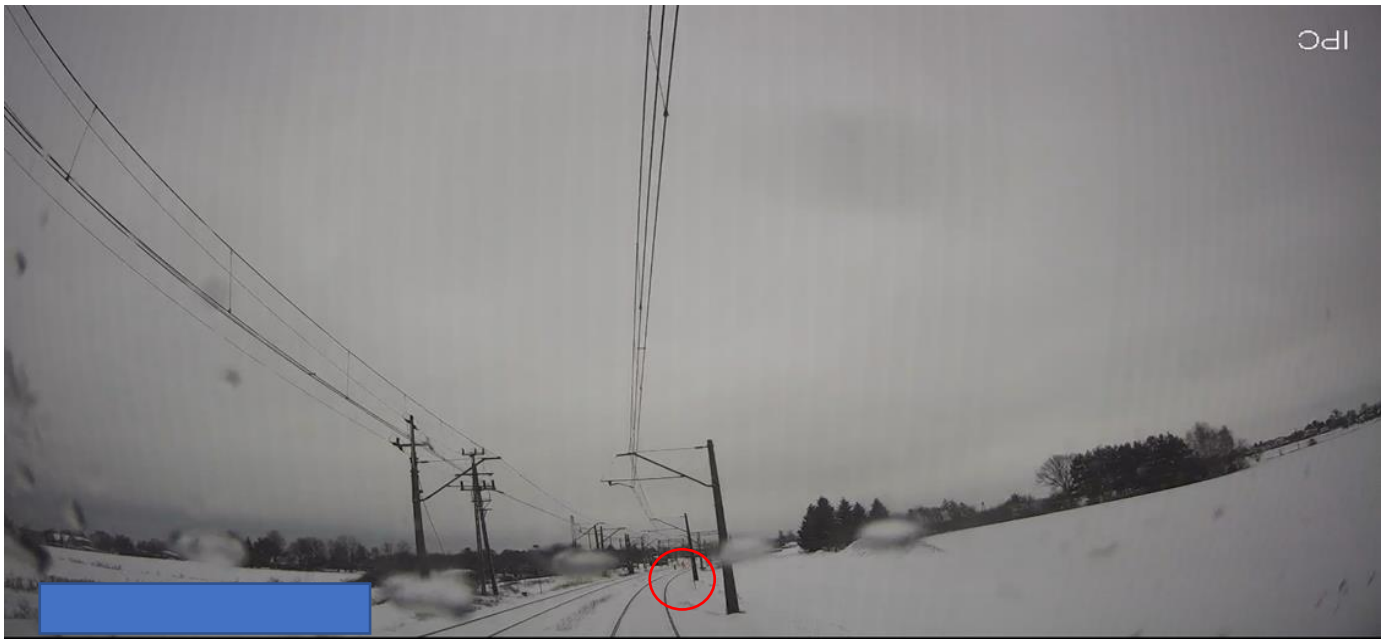
Zdjęcie 3 – Widok z kamery czołowej SA134-019 na pracującą grupę (źródło: POLREGIO S.A.)
