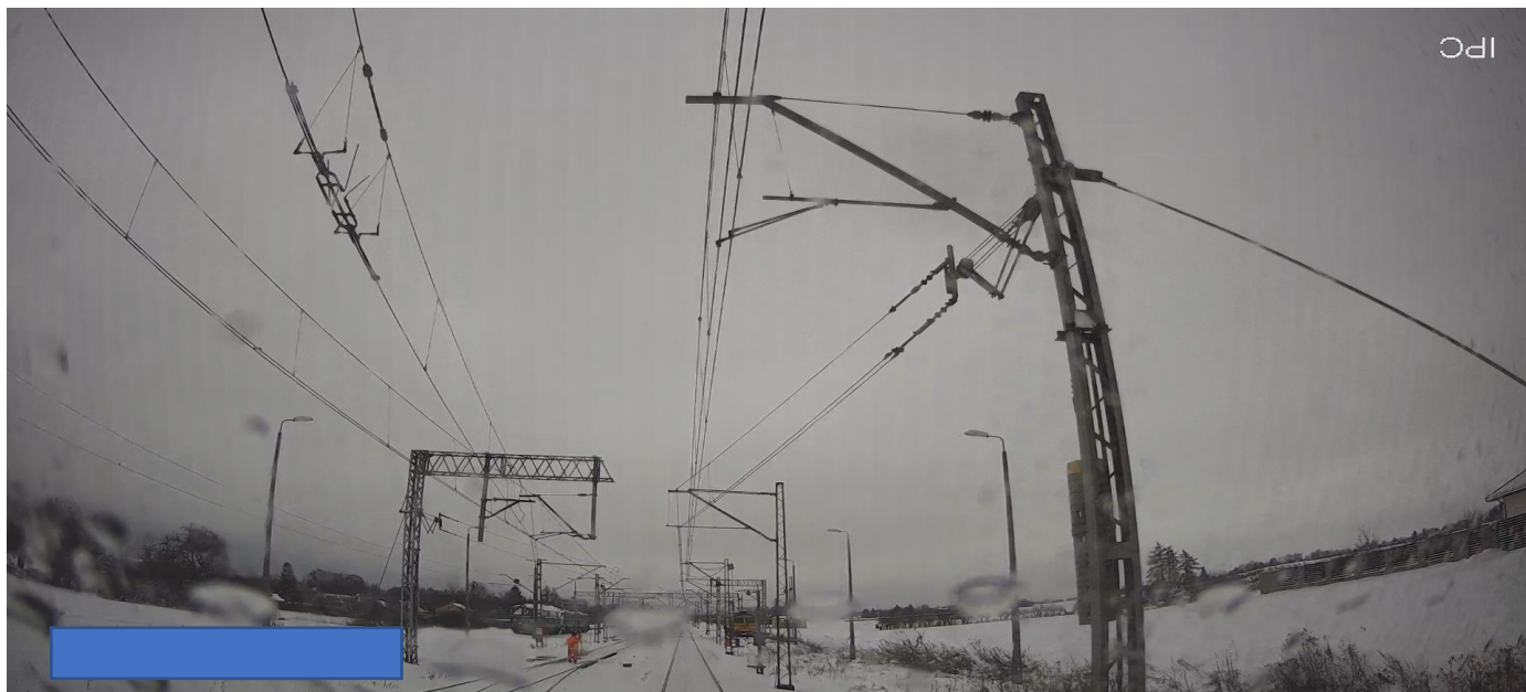
Zdjęcie 5 - Widok z kamery czołowej SA134-019 na trzeciego pracownika, tuż po zdarzeniu i zatrzymaniu pociągu (źródło: POLREGIO S.A.)
