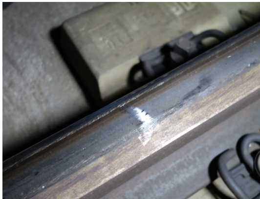
Abbildung 39: Spur auf dem in Fahrtrichtung rechten Schienenkopf (km 46.9–46.8).
