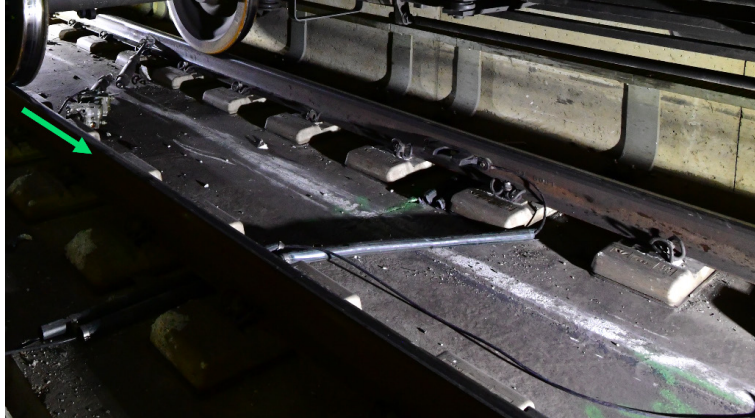
Abbildung 46: Breite Schleifspuren auf dem Betonboden zwischen Weiche W387 und W386 herrührend von der entgleisten Achse 1, Wagen 11. Zwischen den Schwellen der abgerissene Verschluss der Weiche W387.
