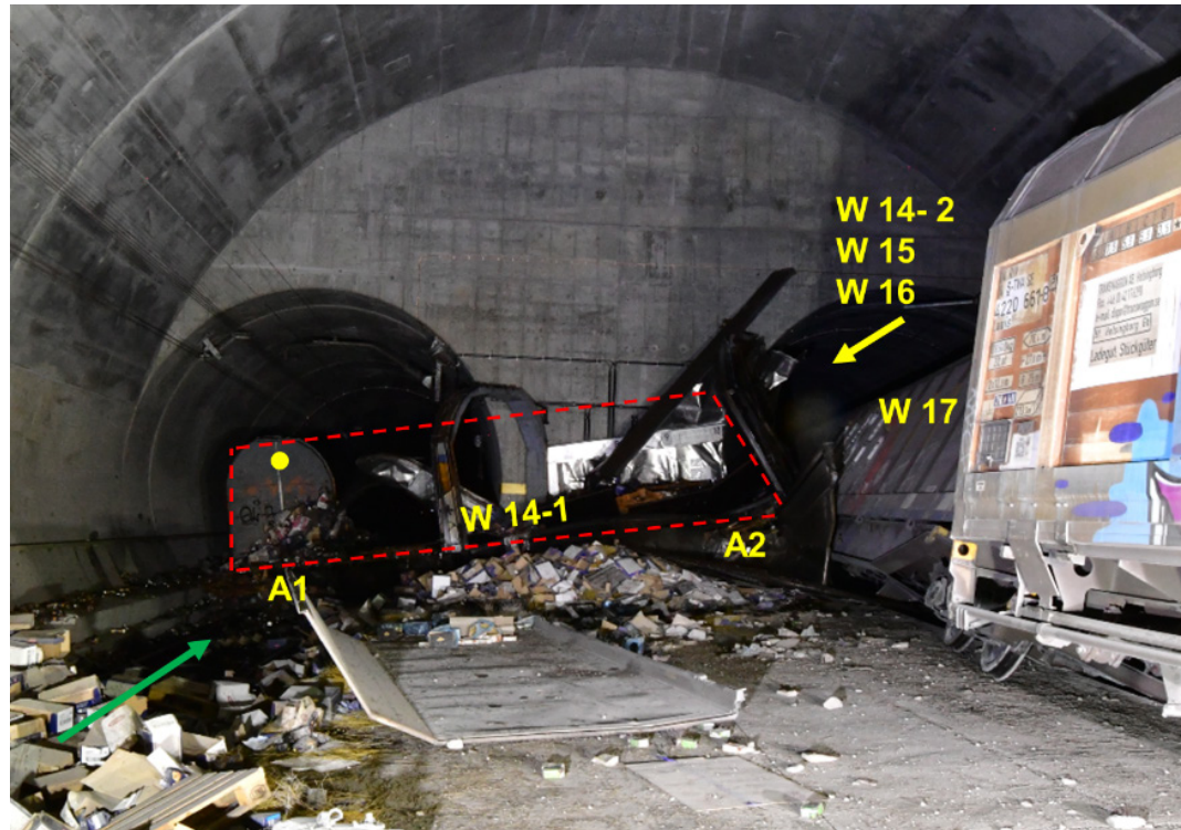
Abbildung 9: Der komplett zerstörte Wagen 14-1 liegt quer an der Tunnelwand auf der Mittelkonsole (Aufnahme in Fahrtrichtung) zwischen Gleis 7000 und dem Verbindungsgleis zur Tunnelröhre Ost. Die gestrichelte rote Linie stellt das effektive Profil von Wagen 14-1 dar. Die Wagen 14-2, 15 und 16 kamen im Verbindungstunnel Richtung Tunnelröhre Ost zum Stillstand.
