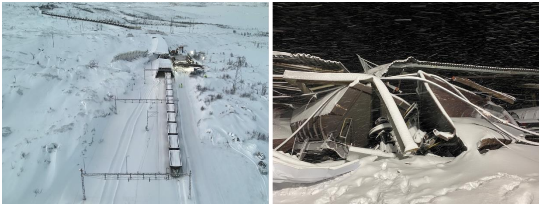
Figur 2 visar i den vänstra bilden de sista vagnarna i tåget och det skadade snögalleriet. I bakgrunden till vänster står tågets främre del mot Riksgränsen. I den högra bilden visas några av de urspårade vagnarna med delar av det raserade snögalleriet över sig.
