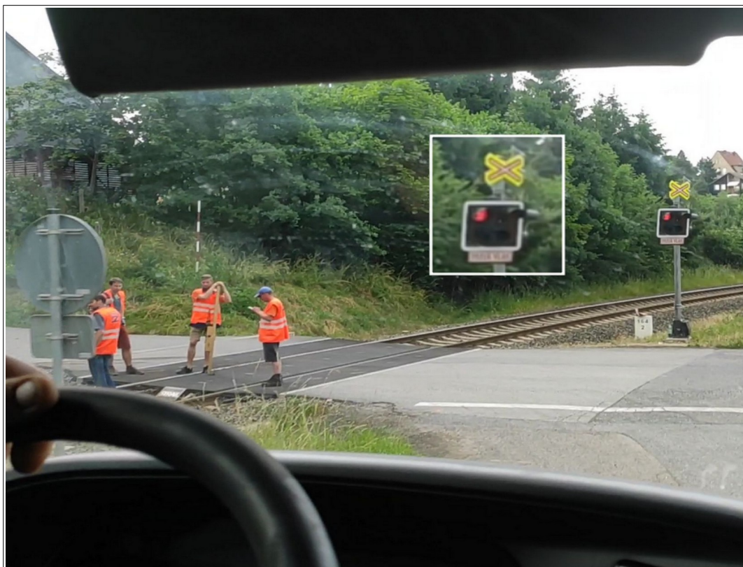
Obr. č. 13: Výstražný signál na výstražníku B2 ve vzdálenosti cca 20 m
