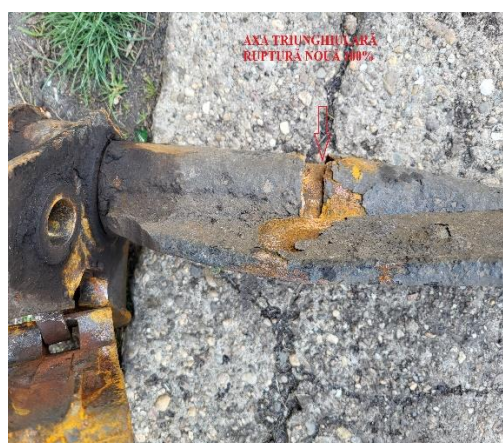
Foto nr.12 axa triunghiulară ruptă nou 100%
